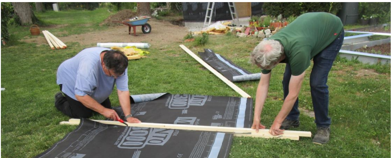
Die Isolierung erhält eine Folienabdeckung
