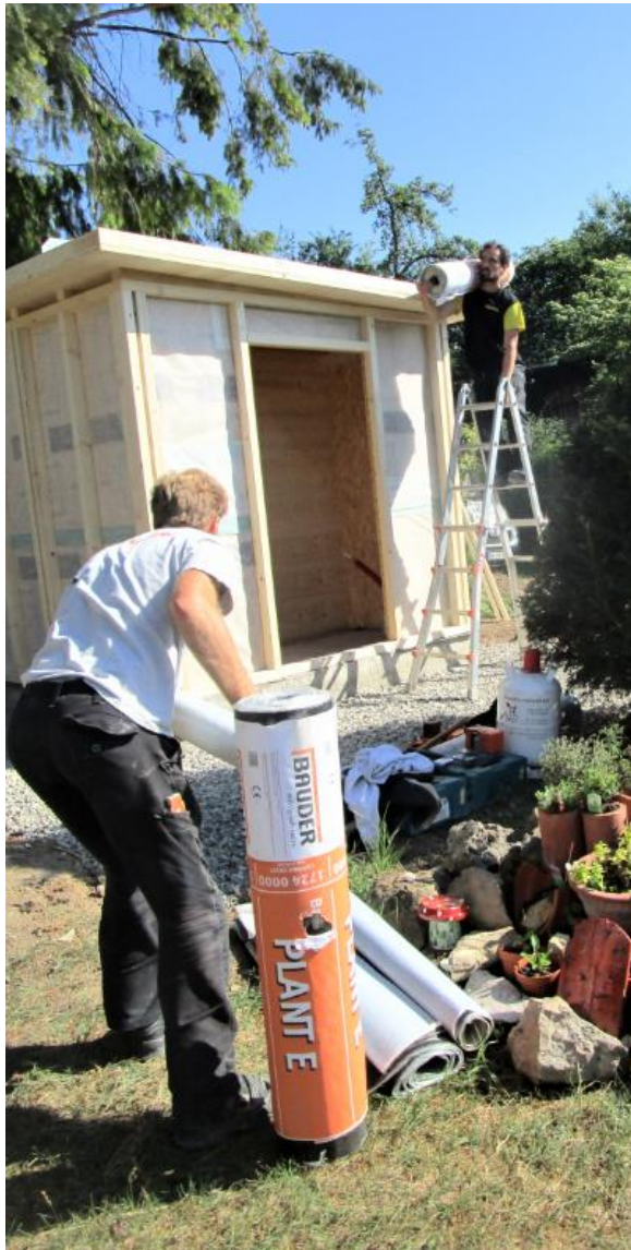
Der Dachdecker führt die Abdichtung aus
