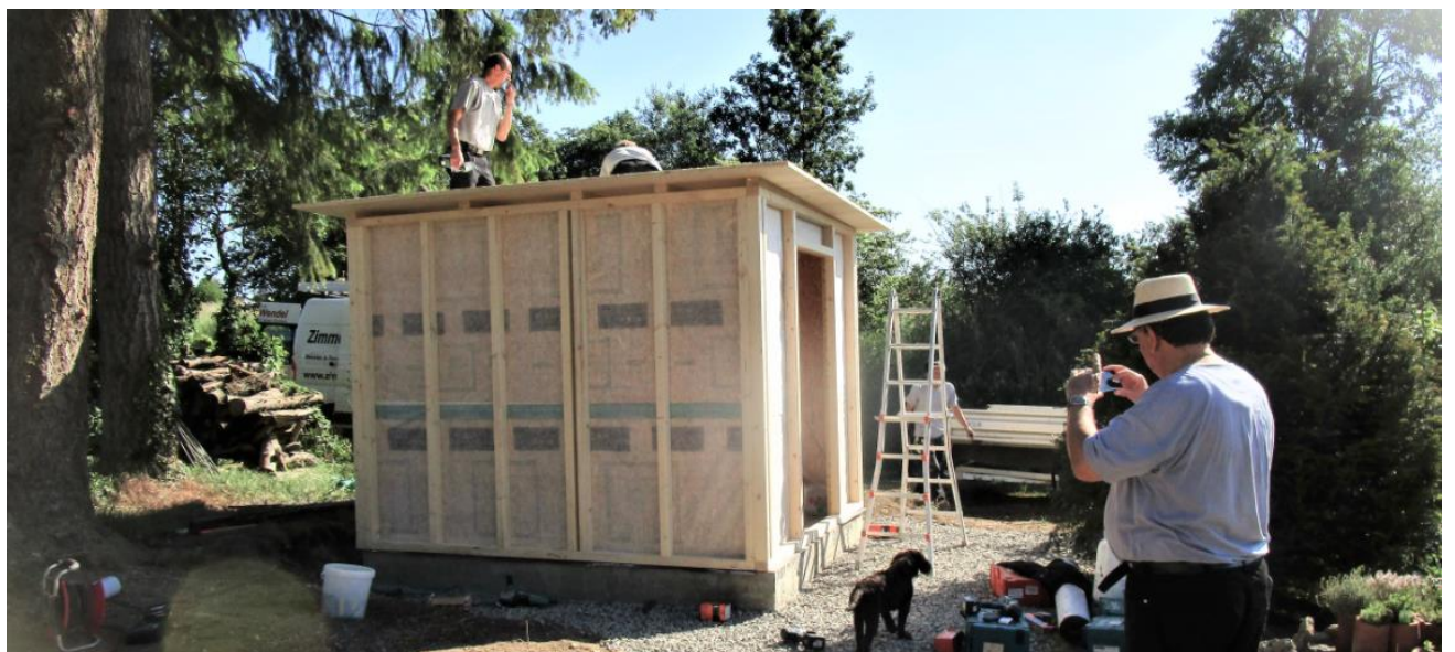
Der Dachdecker führt die Abdichtung aus
