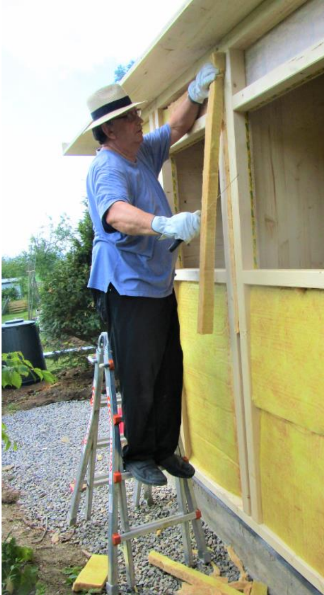
Die Isolierung erhält eine Folienabdeckung
