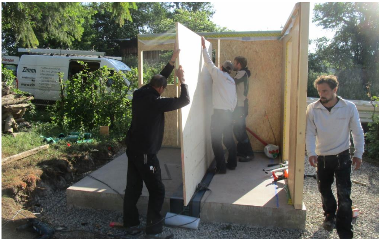
Die Wandelemente werden aufgestellt
