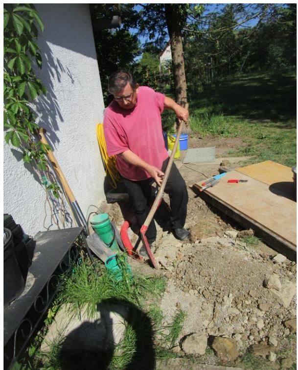
Damit der Boden der WC-Hütte eben und ohne Unebenheiten verlegt werden kann, musste die Bodenplatte noch verspachtelt werden.
