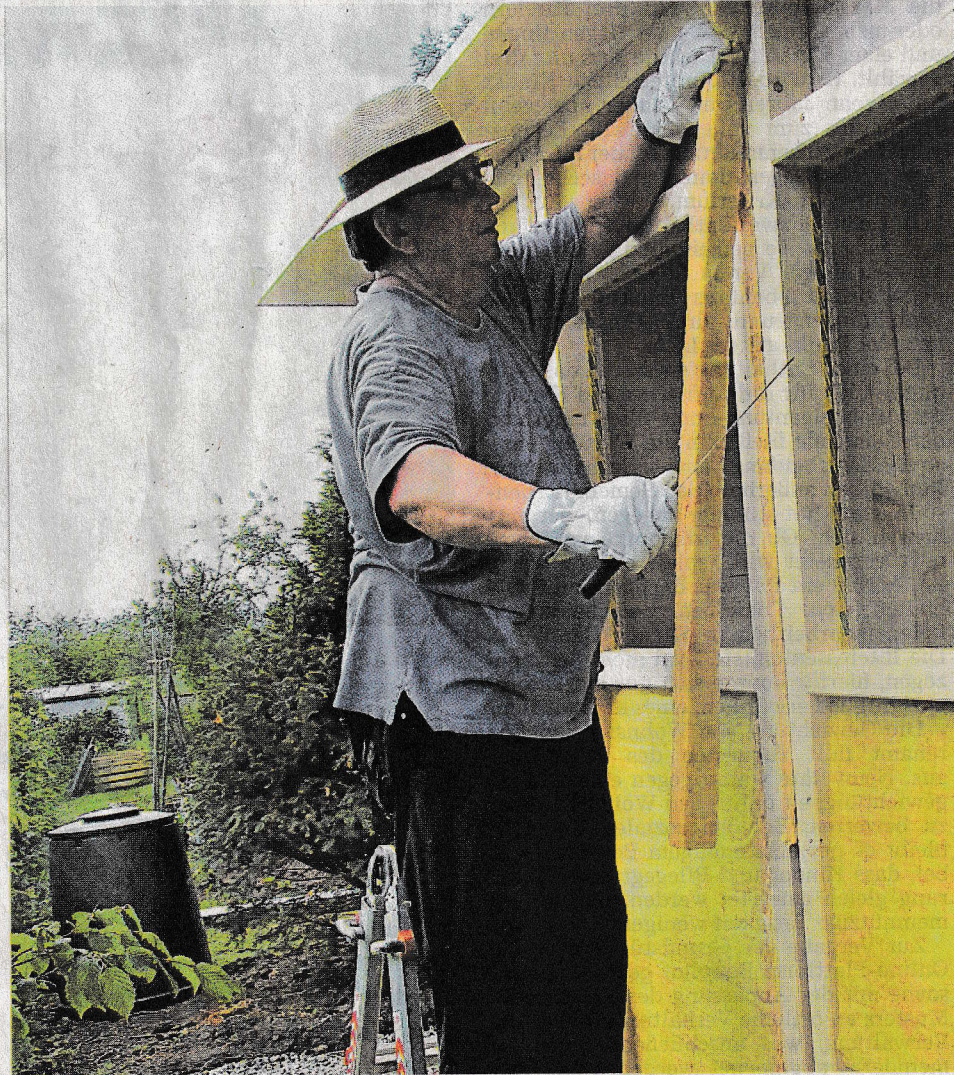
Walter Hühn bringt die Wärmedämmung am WC-Häuschen des OGV Herrenberg an GB-Foto: gb
